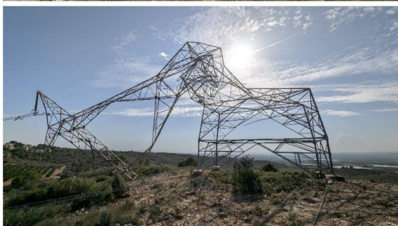
En terreno ascendente a la otra orilla del río, hasta 7 torres colapsaron por efecto dominó Fuente: Javier García (MeteoCarlet)
