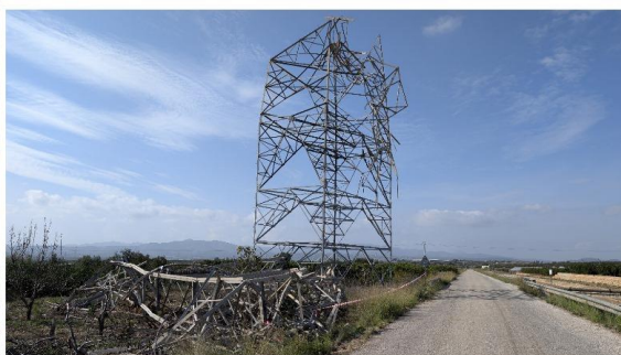
En terreno ascendente a la otra orilla del río, hasta 7 torres colapsaron por efecto dominó Fuente: Javier García (MeteoCarlet)
